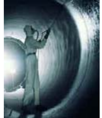
Aplikace nátěru ve vnitřní části turbíny
