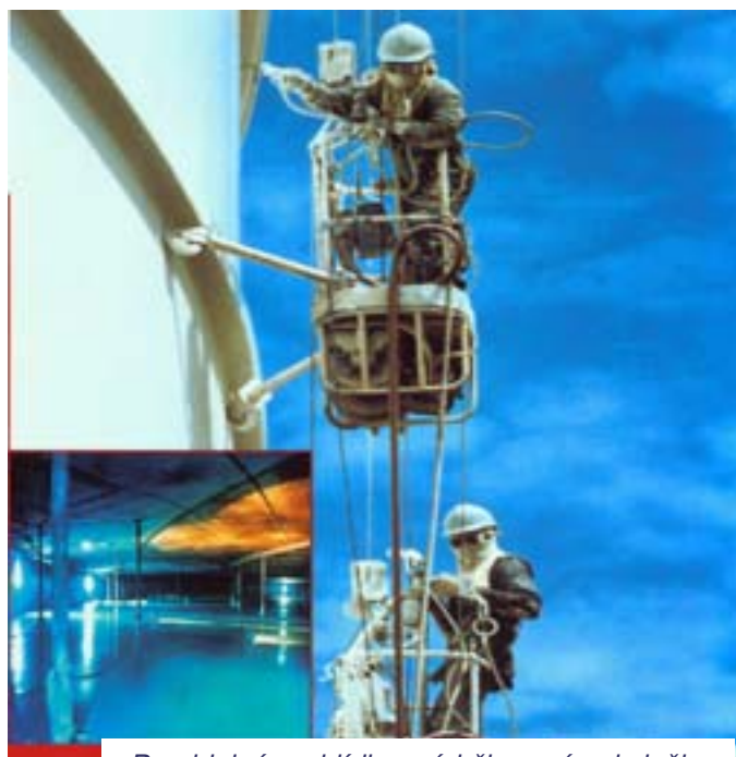
Pravidelná prohlídka a údržba v rámci služby Interplan napomáhá k dosažení požadované životnosti nátěrového systému.
