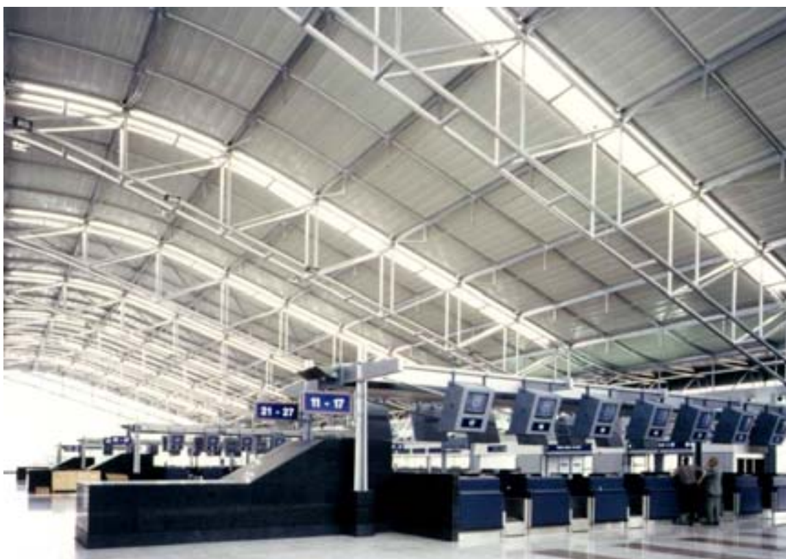
Letiště (interiér odbavovací haly v Ruzyni) Vnitřek vytápěných budov je dle ISO 12944 typické prostředí C2.
