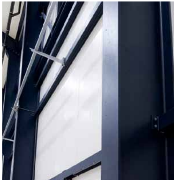
Detail ocelové konstrukce, letiště v Rotterdamu, Nizozemí
